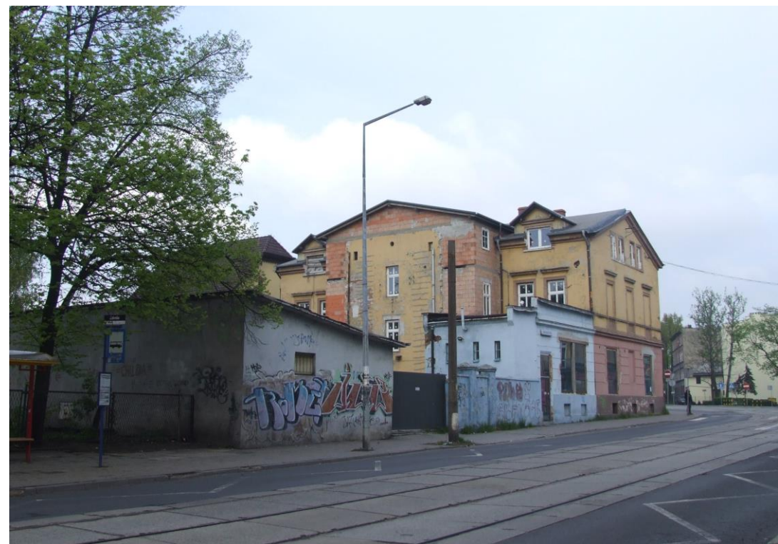
STAN PRZED PRZEBUDOWĄ
